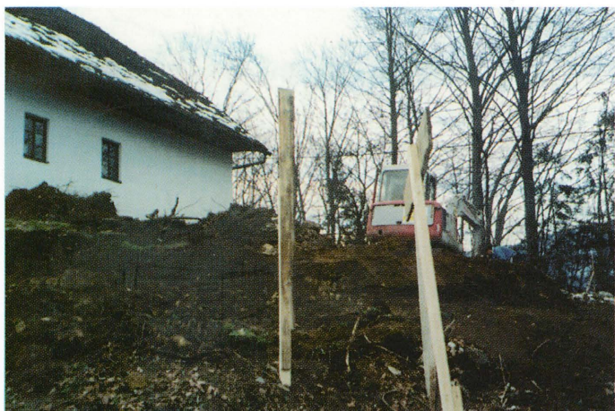
Podjetje Žurbi team je že v začetku leta začelo z izkopavanjem za temelje prvega opornega zidu.
