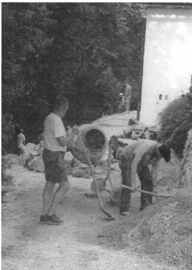
Betonski mešalec se je vrtel kar nekaj delovnih dni.
