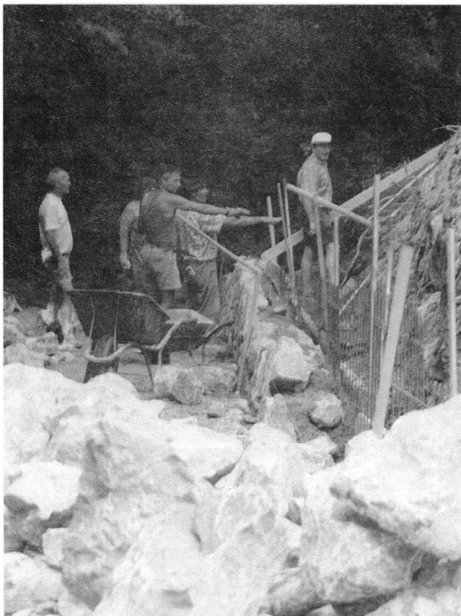
Velike skale in veliko pridnih rok, pa je zrasel nov oporni zid.
