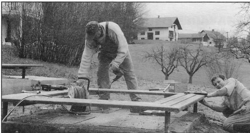
Montiranje klopi pred šolo sta opravila Justin in njegov sin.
