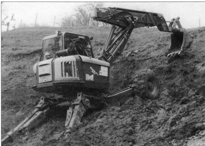
Bager »Pajak« je začel urejati drenažo s hriba proti Zdravilnem gaju.
