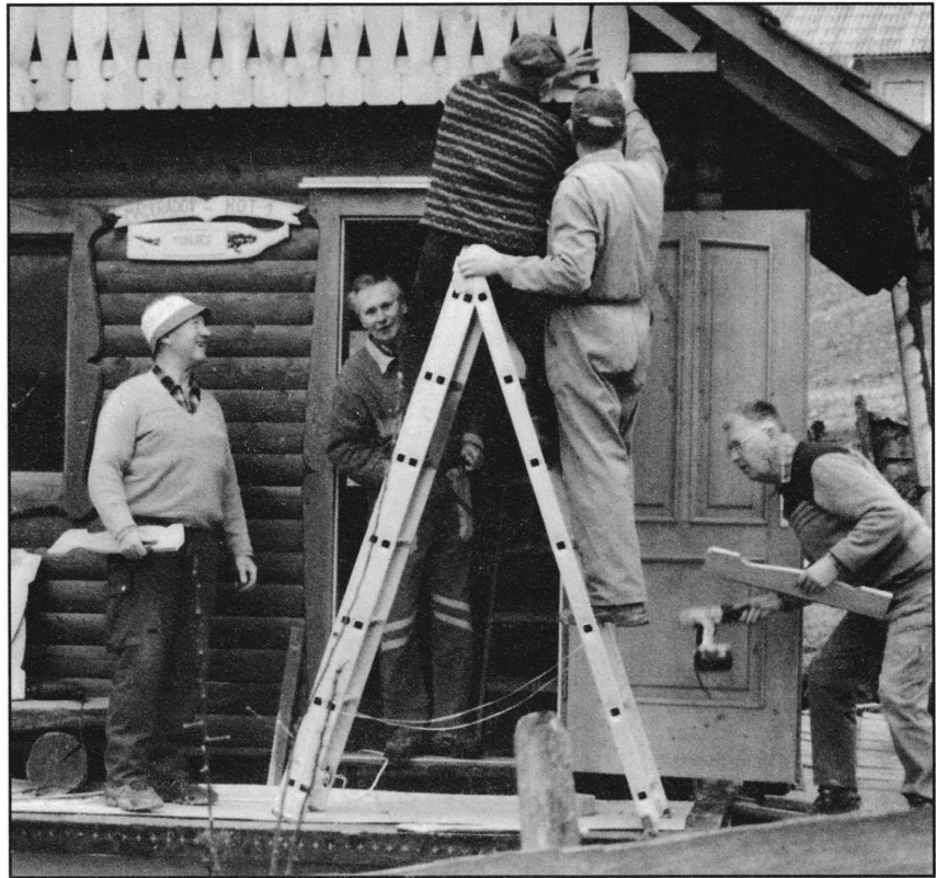
Zaključna dela v Močeradovem kotu
